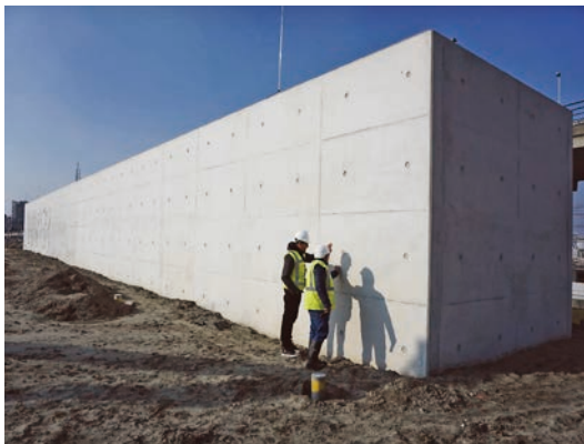
圖 6 鹿特丹港口地面型消防用水儲存槽試驗案例 (2) [2]
