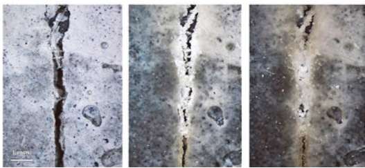
圖 4 生物型自癒混凝土裂縫自修補的過程 [2]
