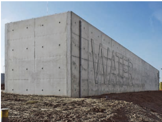
圖 5 鹿特丹港口地面型消防用水儲存槽試驗案例 (1) [2]
